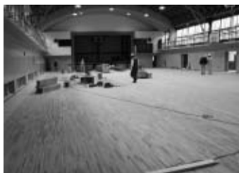
▲改修が進む体育館
